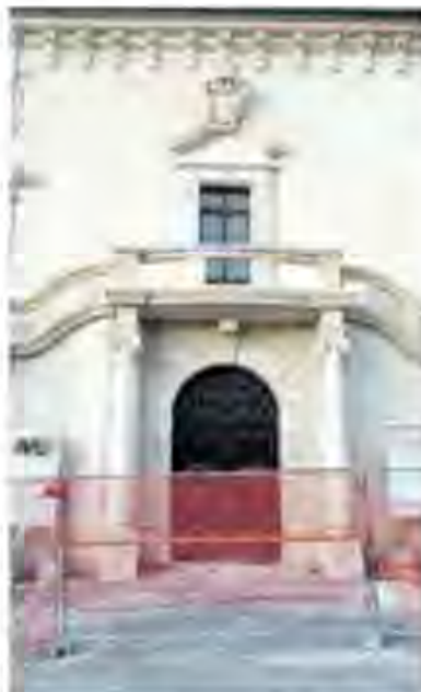
Il Palazzo Ardinghelli alle battute finali del restauro e dell'adattamento museale
